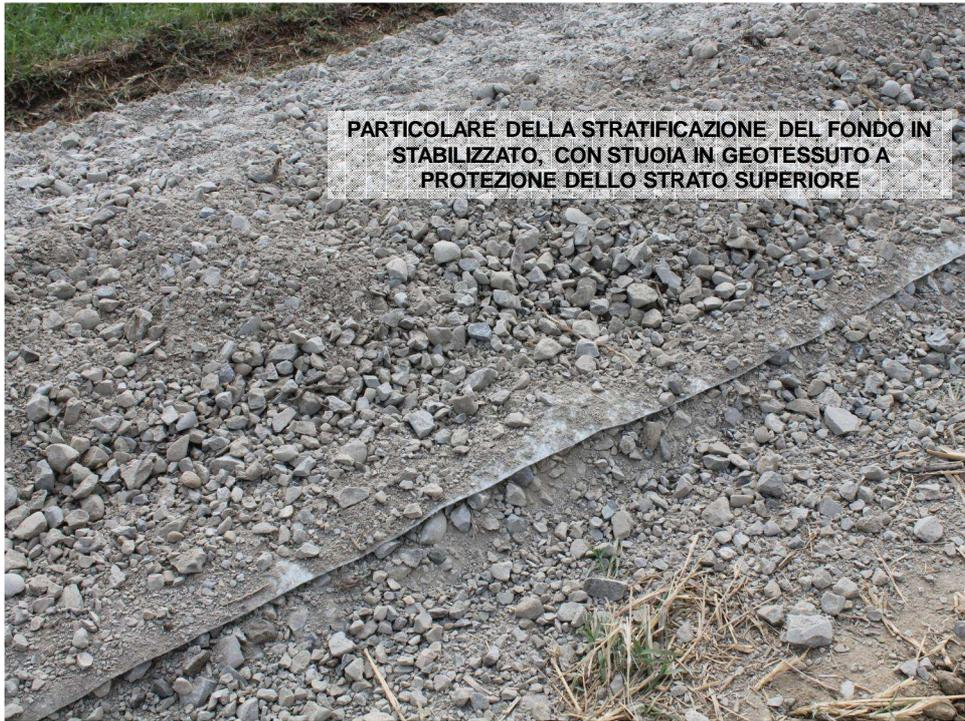
**PARTICOLARE DELLA STRATIFICAZIONE DEL FONDO IN STABILIZZATO, CON STUOIA IN GEOTESSUTO A PROTEZIONE DELLO STRATO SUPERIORE**
